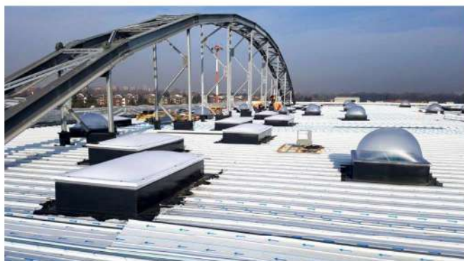
VUE GÉNÉRALE DU TOIT
