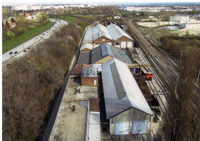
BÂTIMENTS INTÉRIEUR À LA PROPRIÉTÉ (VIENNA)
